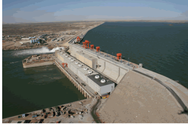
非洲最长大坝——苏丹麦洛维水电站 The longest dam in Africa - Sudan Merowe Dam
